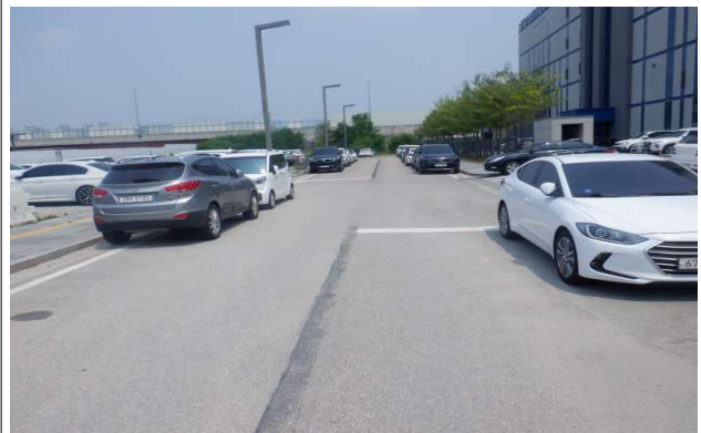
송수-4, 5 종점부 전경
