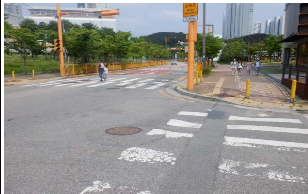
송수-3 시점부 전경
