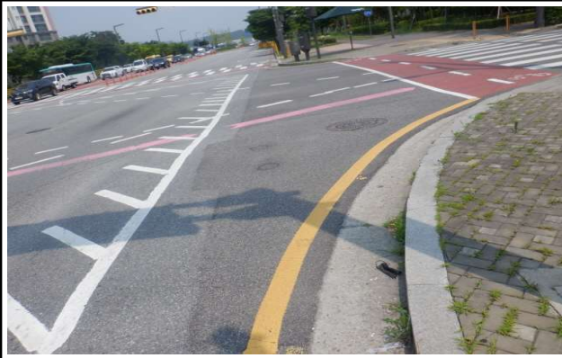
송수-6 시점부 전경
