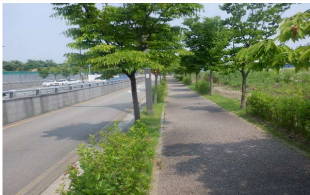
송수-1, 2 시점부 전경
