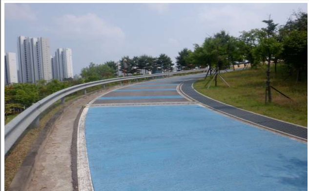
송수-1, 2 종점부 전경
