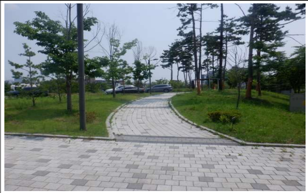
송수-6 종점부 전경
